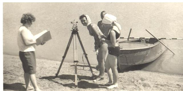
**Теодолитная съемка и измерение уровня грунтовых вод в бассейне оз. Ханка**
